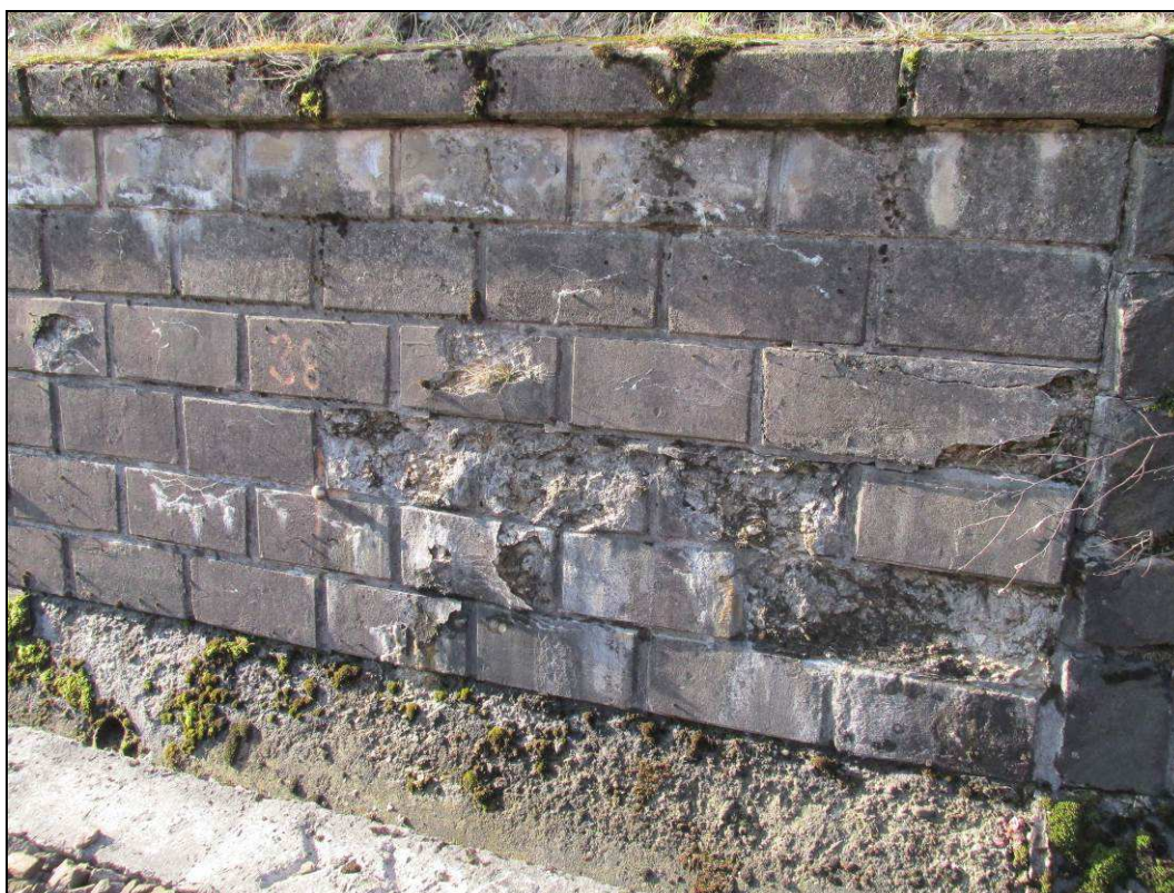
Obr. č. 7 - Detailní pohled na lokální opady betonu na líci opěrné zdi.
