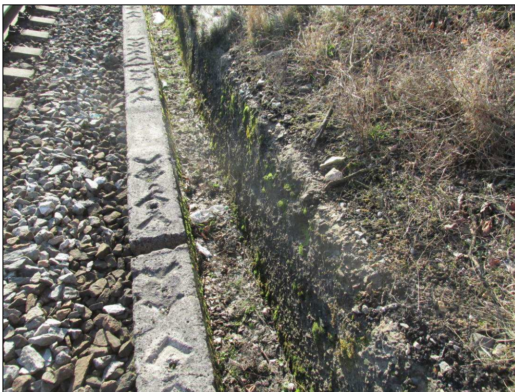
Obr. č. 11 - pohled na zános dna odvodňovacího rygolu při patě „nižší“ opěrné zdi.
